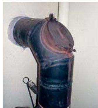
Condotta in fibrocemento attraverso un muro
